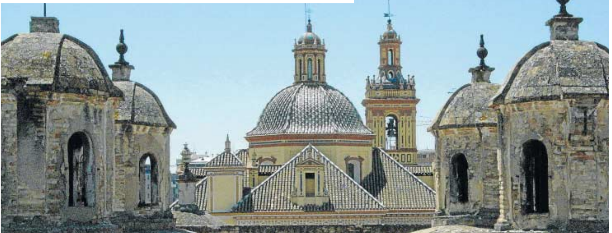
Cubierta de la Real Fábrica de Artillería de Sevilla.
