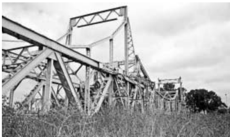
Puente de Alfonso XIII, en Sevilla.
