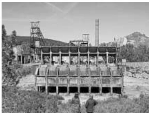
Frente a la tolva. Silo de trituración en Tharsis, en Alosno (Huelva).
