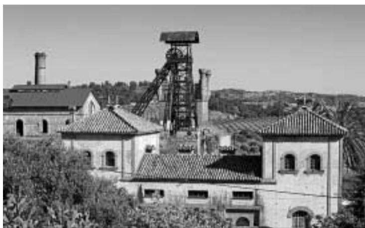
Edificio de la compañía de electricidad Mengemor, en las Minas de la Reunión, en Villaverde del Río y Minas (Sevilla).
